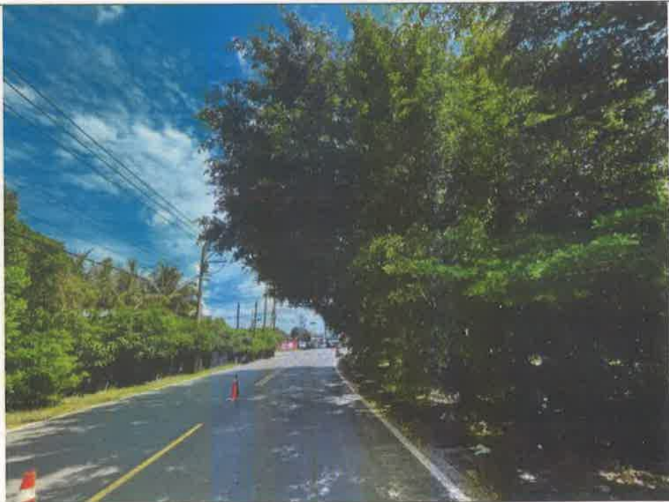
施工前照片2 Photos before construction2
