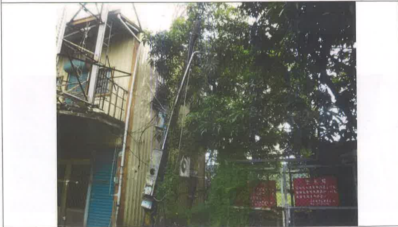
施工前照片2 Photos before construction2
